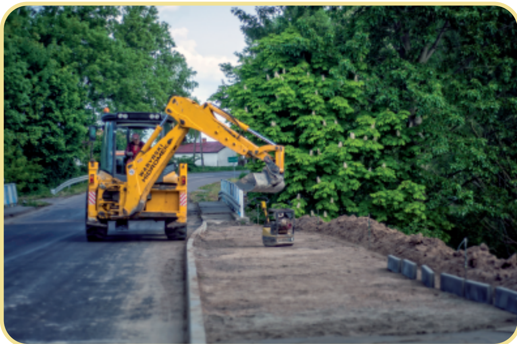
Проект ІРВU.01.03.00-06-318/11 - Поліпшення доступності та якості транскордонної дорожньої інфраструктури Етап ІІ- перебудова ІІ ділянки повітової дороги № 3432L Грубешів – Крилів - Долгобичів - державний кордон та ремонт дороги в Угринові
