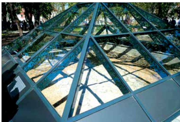
Рис. 5. Фрагмент консерваційного накриття над бруківкою кінця XVII–XVIII ст. Fig. 5. A fragment of the preservation cover over the stone paving of the late XVII–XVIII centuries.
