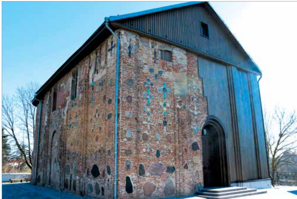
Рис. 3. Борисоглібська церква. На північно-західній стороні після капітального ремонту в 2018 р. Фото С. Піваварчика Fig. 3. The Borisoglebskaya church. The north-west side after the overhaul in 2018. Foto by S. Pivavarchyk
