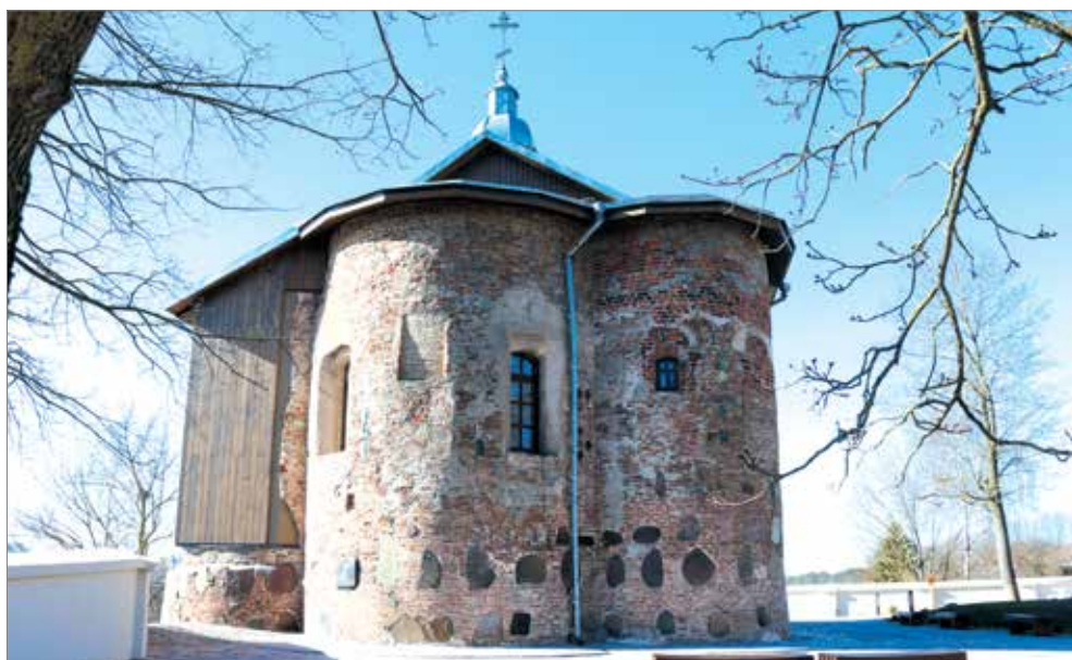
Рис. 2. Борисоглібська церква. Східна сторона після капітального ремонту в 2018 році. Фото С. Піваварчика Fig. 2. The Borisoglebskaya church. The eastern side after the overhaul in 2018. Foto by S. Pivavarchyk
